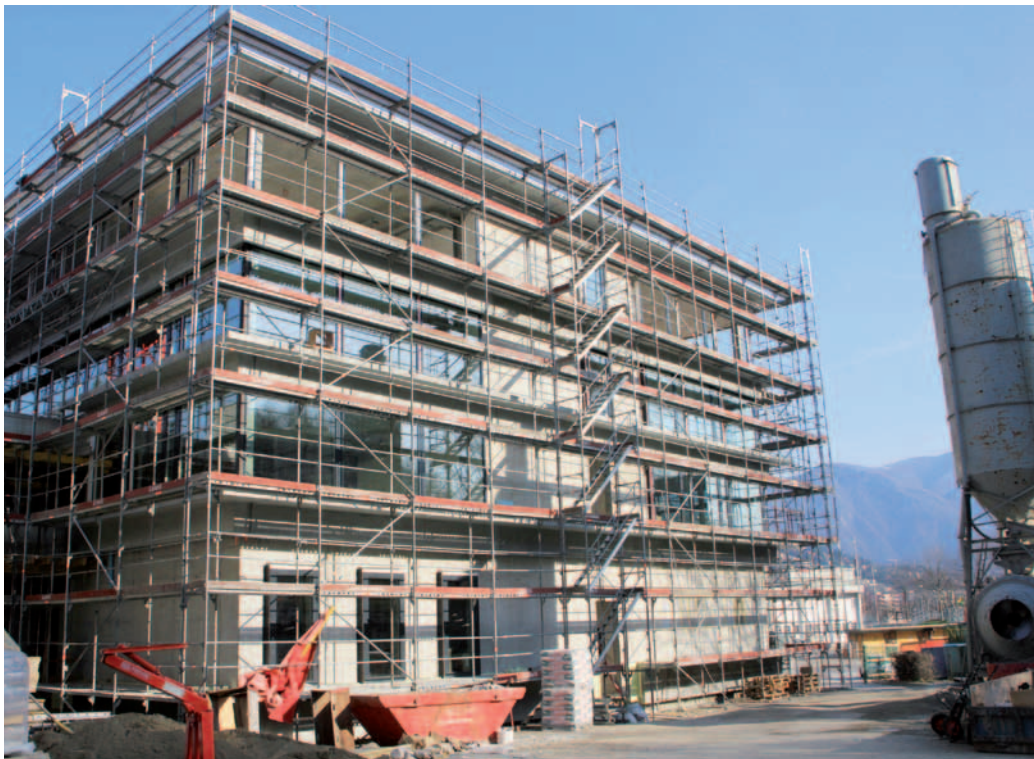
Die Bildungs-, Forschungs- und Innovationsfördermittel für 2012 umfassen auch einen Betrag für den Petaflops-Supercomputer im neuen CSCS-Sitz in Lugano-Cornaredo. (Bild: CSCS/ETH Zürich).
